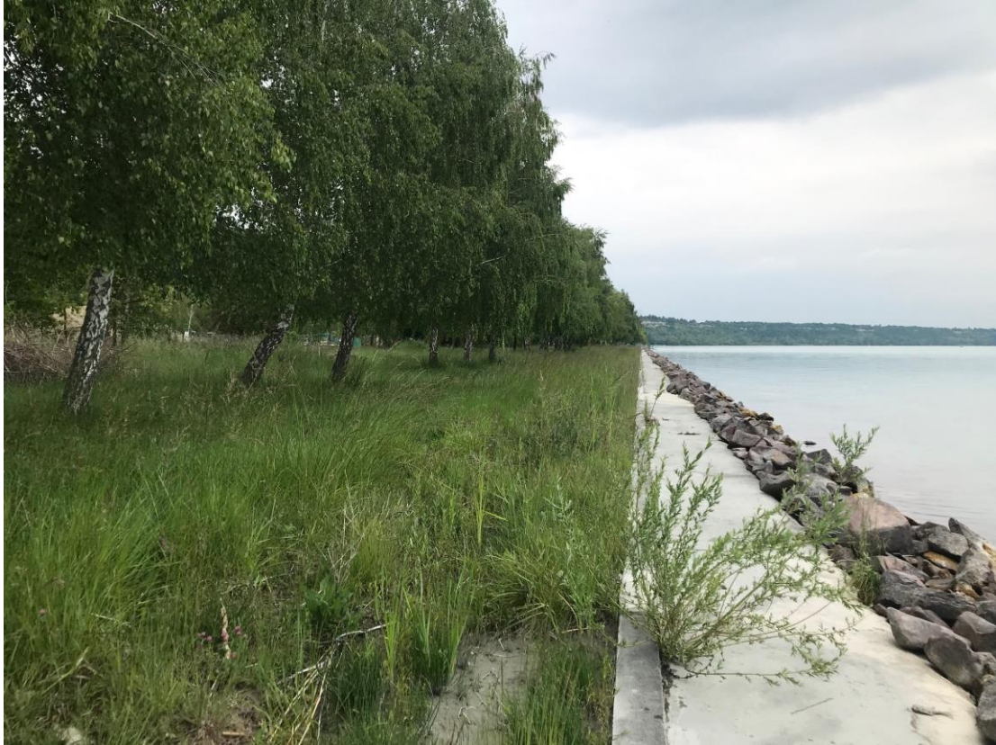
7. ábra: A tervezési terület partja kőszórással biztosított, élőhelyei teljesen átalakítottak.
