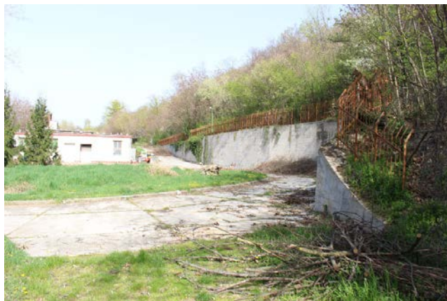
14. ábra. A terület középső részén épített beton támfal
