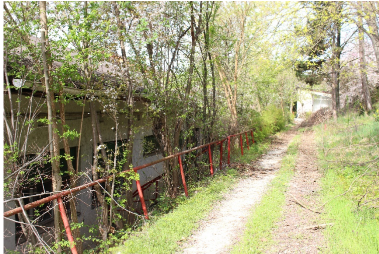
7. ábra. Az egyik épület feletti kidőlt korlát
