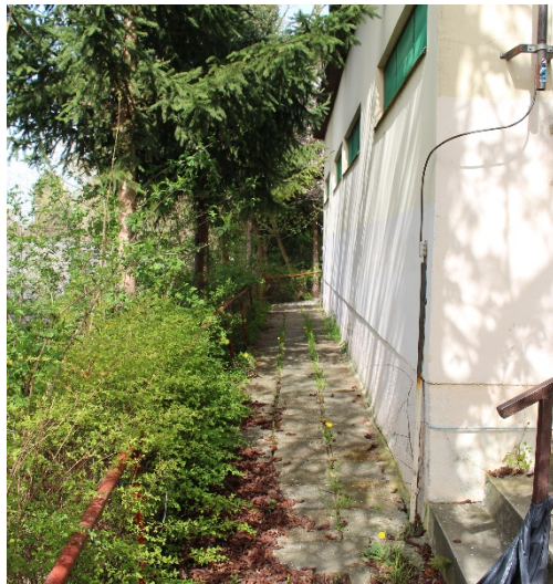
8. ábra. A járdalapok kis mértékben szétcsúsztak
