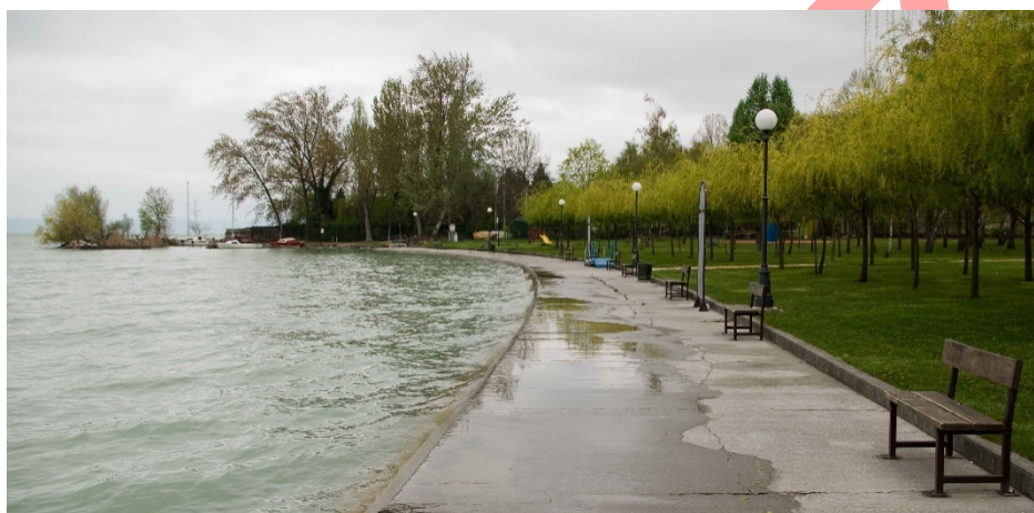
A strandokra is jellemző a morfológiai átalakítottság: módosított part-vonalvezetés és vasbeton partvédő művek (Fotó: B.Zs.)
